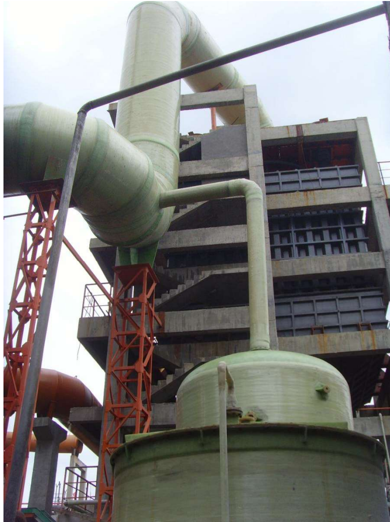
硫磺制酸尾气除尘改造项目
