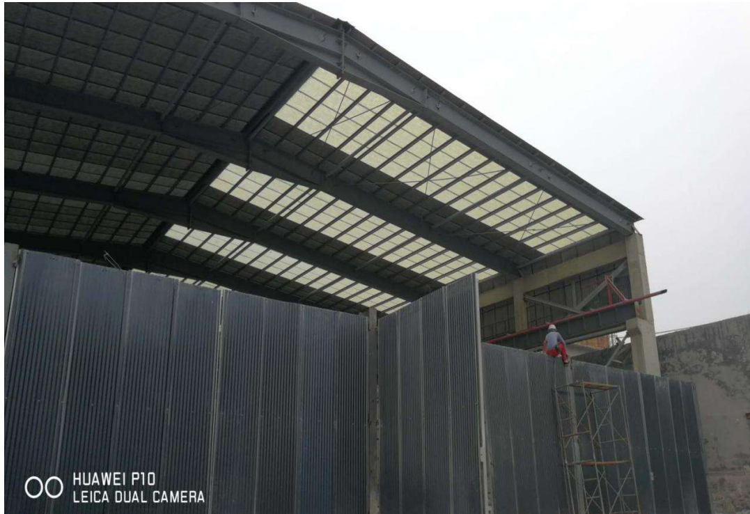
电石泥料场封闭
